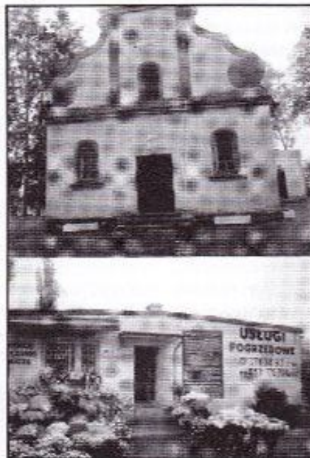
Zabytkowa kaplica i nowy sklep z akcesoriami.
